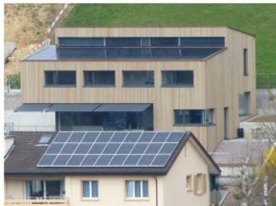
Foto: Neubau (hinten) – Indach-PV-Anlage, vorne Aufdach-PV-Anlage
