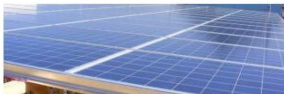
Indach Anlage (PV-Module ersetzen herkömmliches Dach) mit 30 kWh Leistung.
