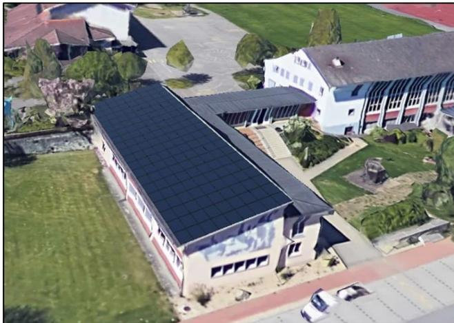
Auch das Südtrakt-Dach soll mit einer PV-Anlage ausgerüstet werden (in-Dach Lösung). Die Leistung der geplanten Anlage wird 72kWp liefern.
