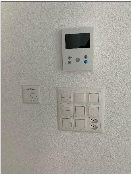
Von hier aus werden die Hausglocke mit der Gegensprechanlage, die Heizung, die Lamellenstoren und das Licht bedient.
