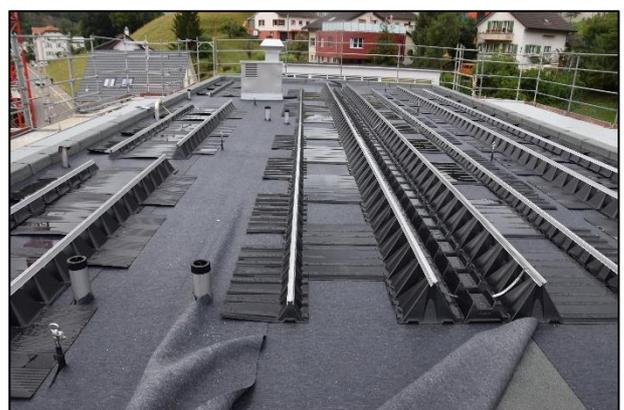
Auf dem Haus B ist die Unterkonstruktion für die Photovoltaikanlage erstellt und die Panels sind bereit zur Montage.
