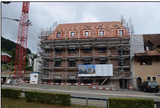
Nach dem der Fenstereinbau abgeschlossen wurde, konnte mit der Aufbringung der Aussendämmung begonnen werden.
