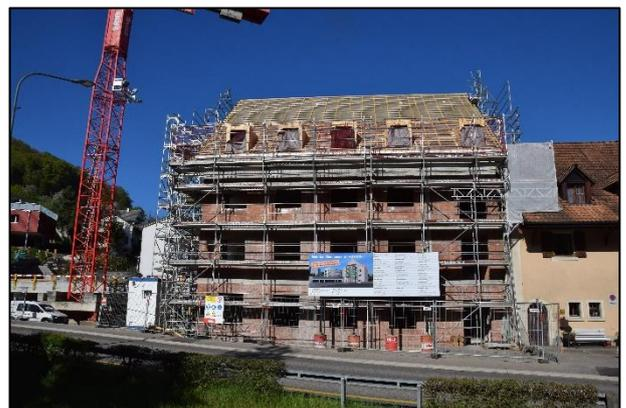
Und auf dem Steildach sind die Dachgauben montiert und die Ziegellattung ist bereit für das Eindecken mit den Ziegeln
