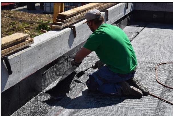
Ansonsten läuft es auf der Baustelle rund. Auf den Flachdächern sind die Dachränder montiert und die Bauabdichtungen ausgeführt
