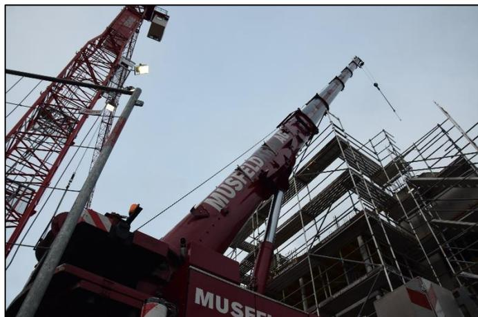
Mit Hilfe eines Pneukrans der Musfeldkran AG wurden die vorgefertigten Betontreppen für das Treppenhaus ins Haus A gehoben.
