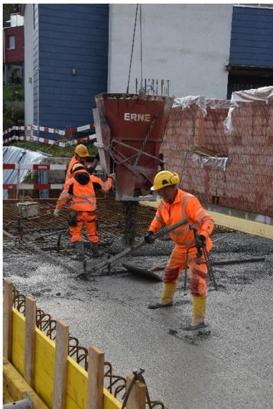
Die Rohbauarbeiten sind voll im Gange und es werden täglich 10 – 40 m<sup>3</sup> Beton verarbeitet.
