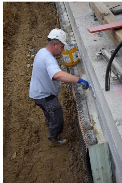
Bevor das Gebäude hinterfüllt werden kann, müssen sämtliche Arbeitsfugen abgedichtet werden, damit kein Wasser in das Gebäudeinnere eindringen kann.
