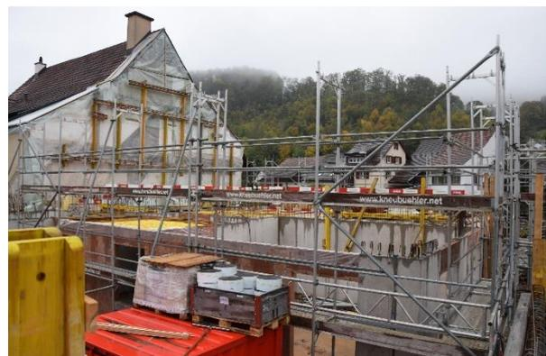
Dabei wird Stockwerk für Stockwerk das Gerüst mitgezogen, damit die Sicherheit der Arbeiter auf der Baustelle gewährleistet ist.
