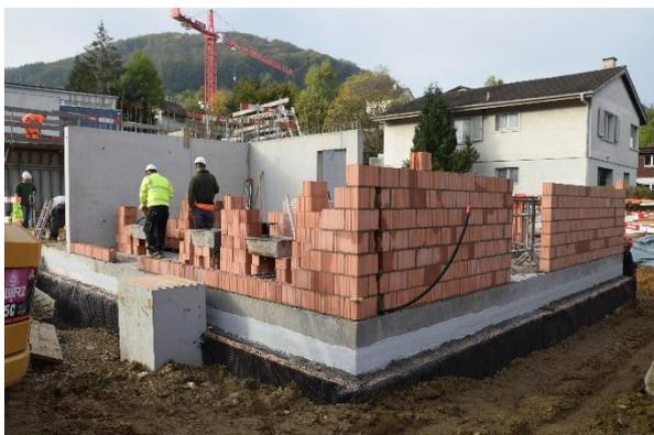
Nach dem Betonieren der Betondecken wird das Mauerwerk ausgeführt.
