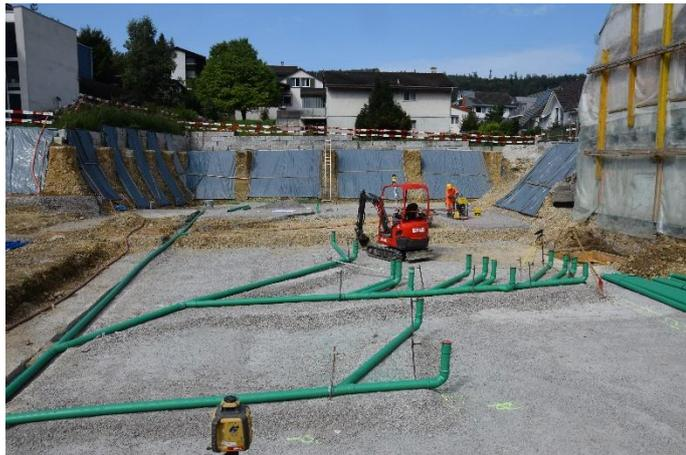
Anschliessend wurde die Dämmung unter der Bodenplatte (Schüttung von Schaumglasgranulat) eingebracht und die Kanalisation eingepackt.
