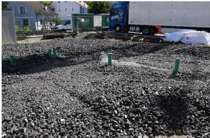
Nach der Verdichtung der Schüttung konnte die Armierung der Fundamentplatte verlegt und die Fundamentplatte betoniert werden.
