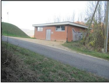
Die Pumpstation Büchel der Wasserversorgung Zunzgen wurde im Jahre 1968 gebaut. Das Gebäude dient im Untergeschoss als Auffangbecken (200 m<sup>3</sup>) des geförderten Grundwassers. Hier wird das Rohwasser aufbereitet und anschliessend in das Versorgungsnetz und in die beiden Reservoirs gepumpt. Im Erdgeschoss sind die Netzpumpen, die UV-Anlage und die Steuerungsanlage eingebaut.
